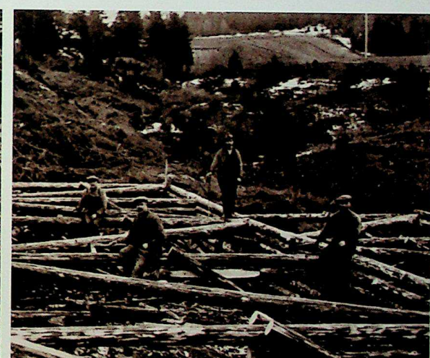
Kraftstasjonens underbygning, januar 1921.
