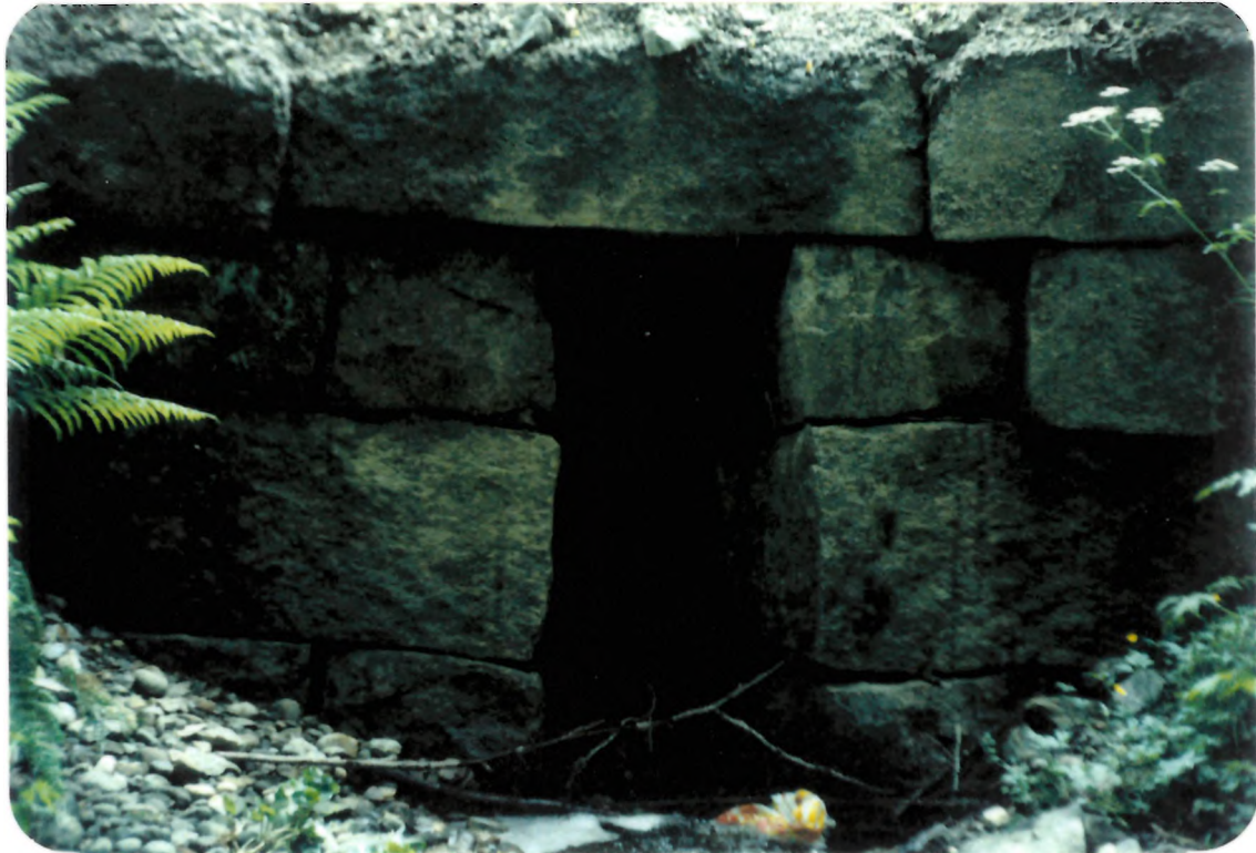
Nåværende Trøgstadvei som ble ferdig 1911 passerer bekken mellom Olberg og Boslet over denne fine konstruksjonen.
